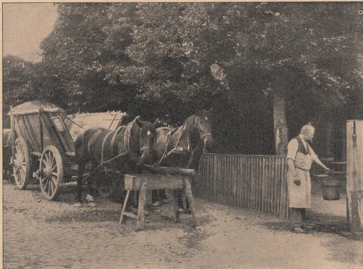
Vor dem Rollkrug an der Landstraße.
